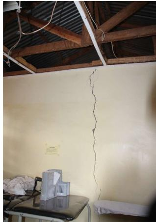
Risse in Wänden und Böden, Decken und Dachstuhl von Termiten teils zerstört
