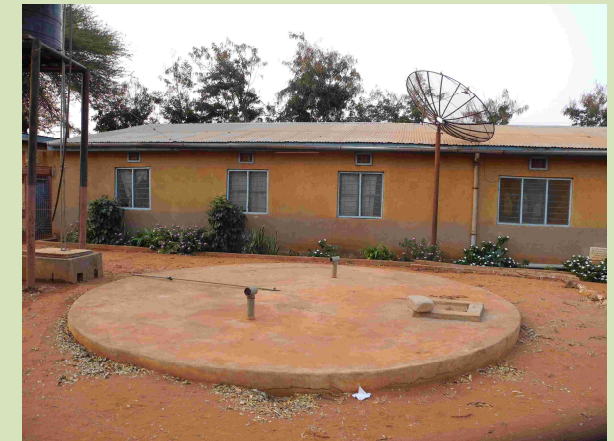
Regenwasseranlage Kongwa 110.000 Liter
